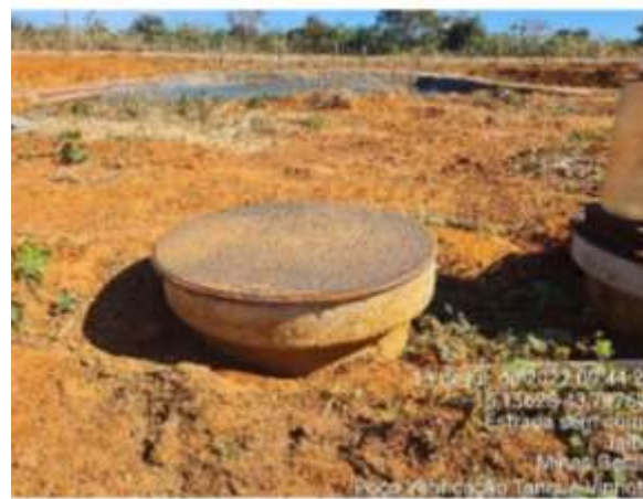
Foto 10 - Ponto de inspeção do dreno testemunho
