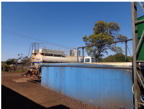
Foto 03. Área da ETE
