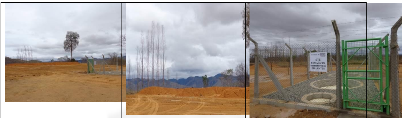
Figura 7: Aterro Classe II com ETE
