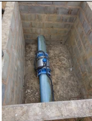
Figura 15: Sistema de controle de vazão da captação em curso d' água
