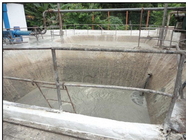
Foto 04: Tanque de decantação do efluente da depilação.
