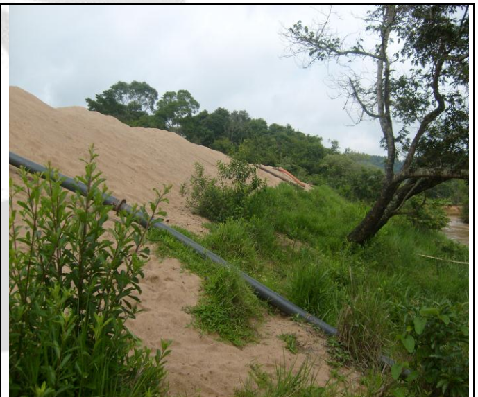
Foto 06: passagem do mangote para o porto.
