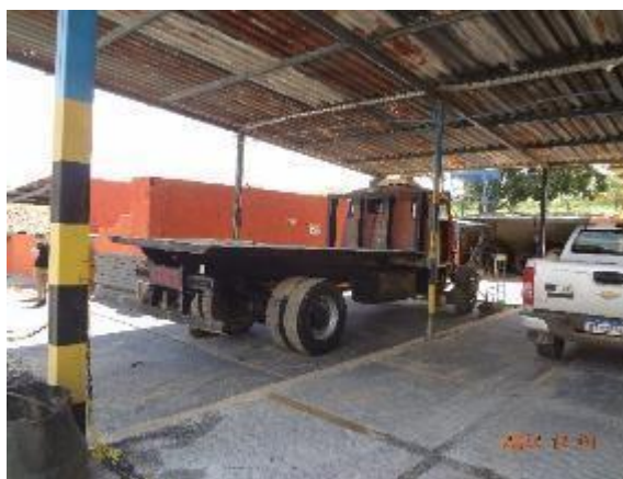
Foto 23 – Piso em chapas de ardósia com rejunte de cimento na área da oficina. Área em bom estado de conservação.
