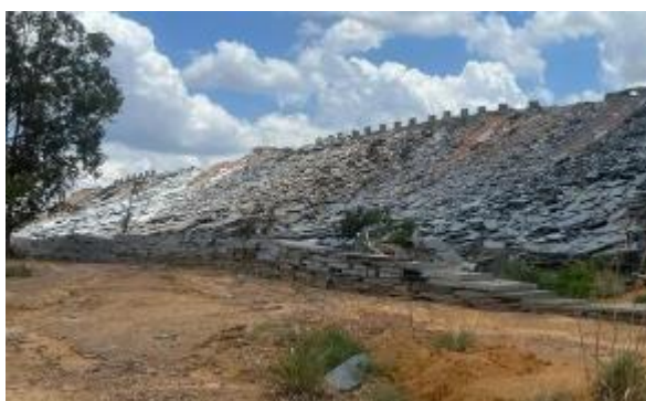
Foto 15 – Muro de contenção de material empilhado e sedimentos na lateral da pilha em operação, em sua porção nordeste.
