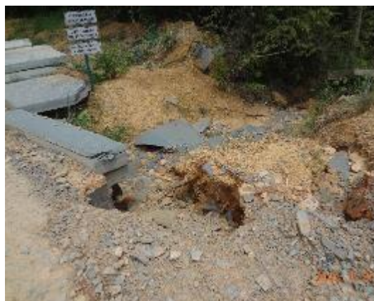
Foto 08 – Início de processo erosivo na latera ponto de acúmulo de água (23k 544.065/7.873.8
