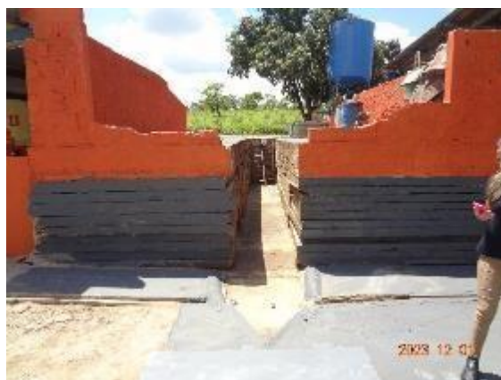
Foto 27 – Canaletas na área da rampa de manutenção ao lado da oficina.
