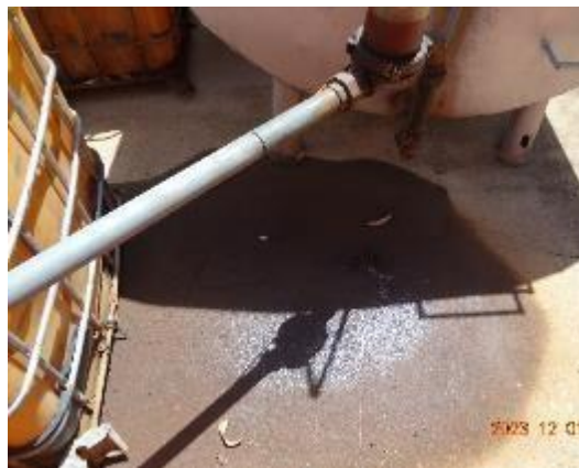
Foto 32 – Detalhe de vazamento de óleo dentro da bacia de contenção do tanque.
