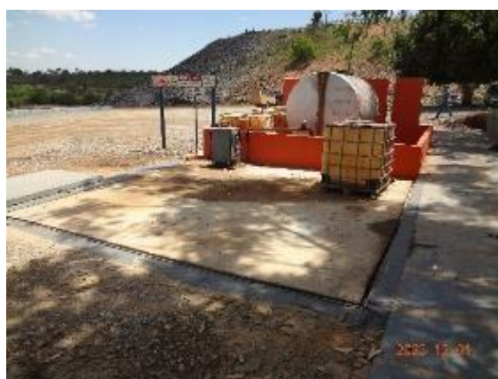
Foto 29 – Área do ponto de abastecimento. Foi constatada a existência de piso impermeável com algumas trincas, circundado por canaletas coletoras ligadas à CSAO.
