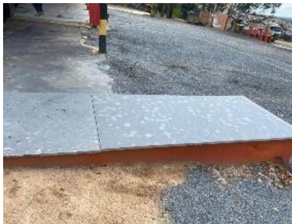
Foto 19 – Caixa separadora de água e óleo da oficina vedada com as chapas de ardósia.
