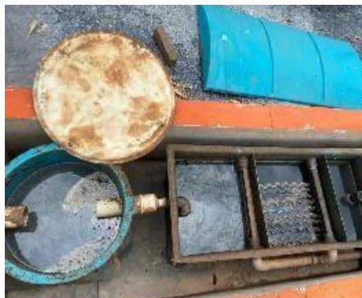
Foto 22 – Aspecto do efluente no interior da estrutura da CSAO.
