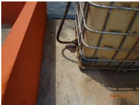
Foto 31 – Detalhe de vazamento ocorrido em uma bombona dentro da pista de abastecimento.
