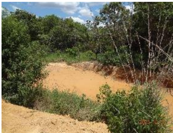
Foto 13 – Bacia de sedimentação a jusante da pilha em operação.
