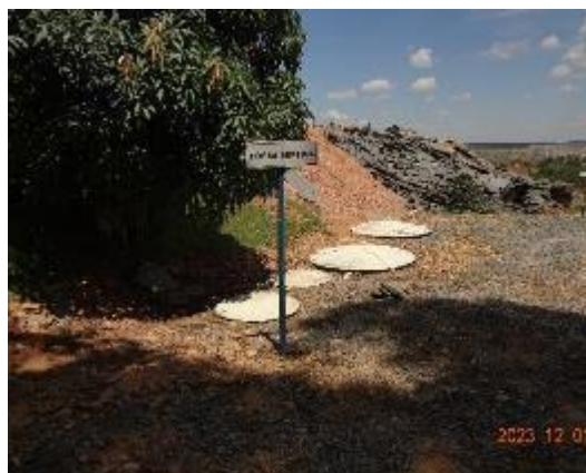
Foto 34 – Sistema de fossa séptica que recebem o efluente do refeitório e das instalações sanitárias.
