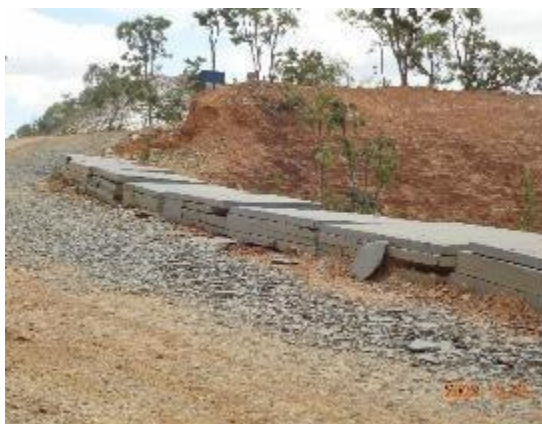
Foto 06 - Material sem valor econômico sendo utilizado para proteção contra formação de processos erosivos no acesso à cava.
