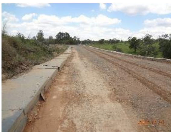
Foto 17 – Material de descarte utilizado para direcionamento de água pluvial e controle de processos erosivos ao longo dos acessos.
