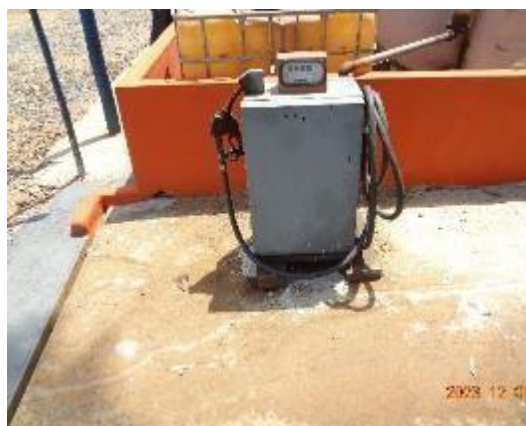
Foto 33 – Bomba de abastecimento. Piso impermeabilizado.
