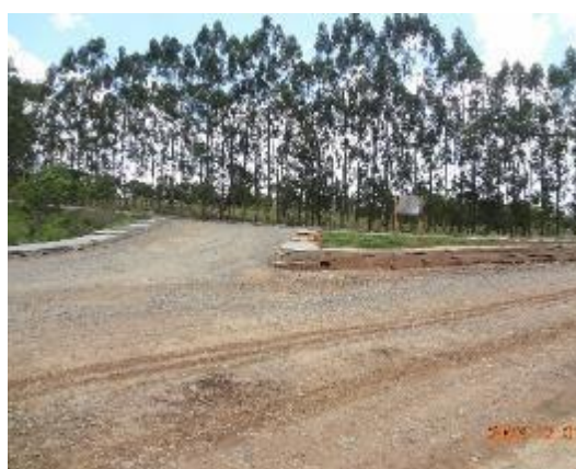
Foto 18 – Material sem valor econômico sendo utilizado para proteção contra formação de processos erosivos e formação de canteiro em umtrevo dentro da área de servidão doempreendimento.
