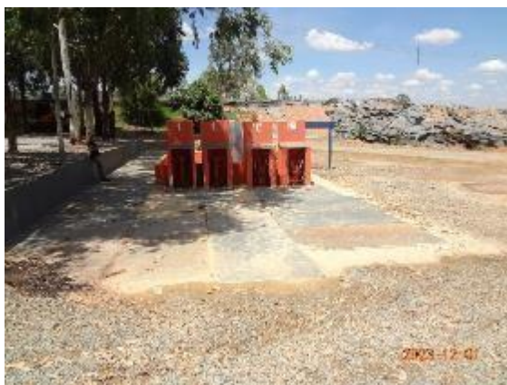
Foto 34 – Extintores de incêndio localizados na lateral da bacia de contenção do tanque de combustível.
