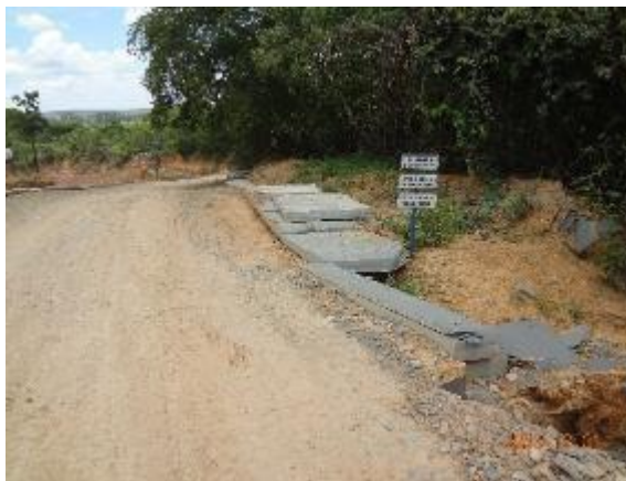
Foto 07 – Ponto em que há um maior acúmulo de água de chuva dando início a um processo erosivo.
