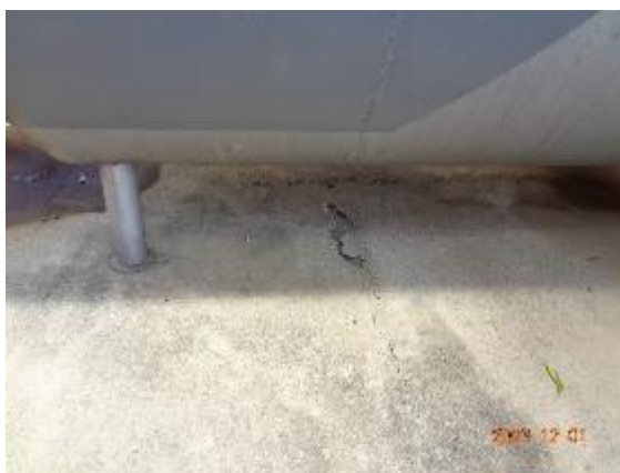
Foto 32 – Detalhe de uma pequena trinca no piso da bacia de contenção do tanque de combustível.
