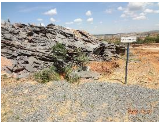
Foto 35 – Estrutura denominada de “Vala sanitária” onde é lançado o produto final da fossa séptica.
