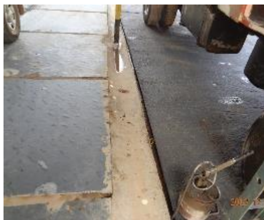
Foto 26 – Canaletas na área da oficina. Limpas e em bom estado de conservação.
