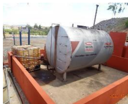
Foto 30 – Tanque de combustível em bacia de contenção.
