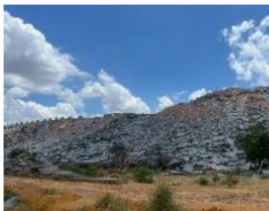
Foto 14 – Lateral da pilha em operação. Comopode ser observado não há formação de bermas.
