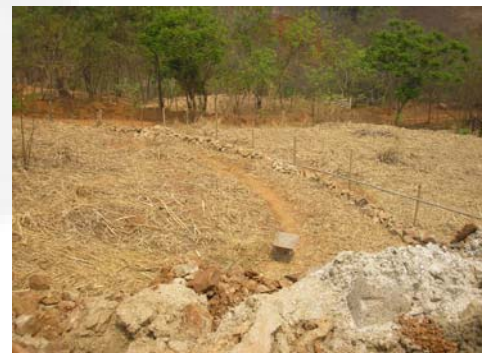
Foto 04. Sistema de Contenção
