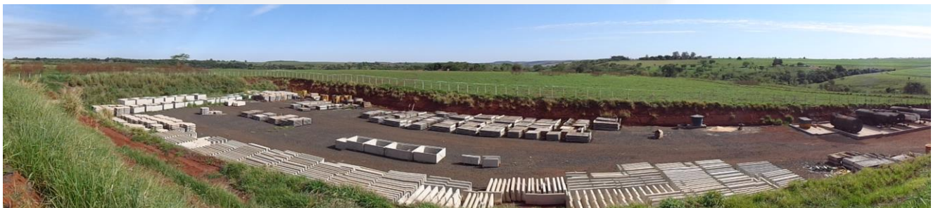
Foto 01. Visão geral da área de implantação da usina de asfalto.
