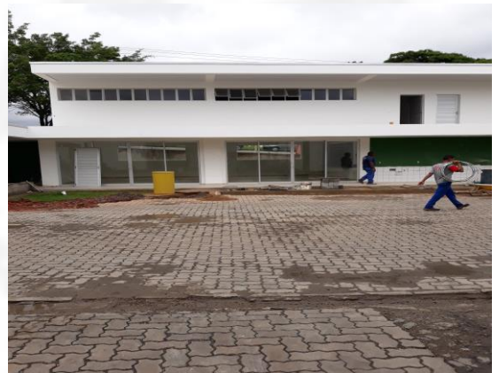
Foto 04: Novas instalações do refeitório.
