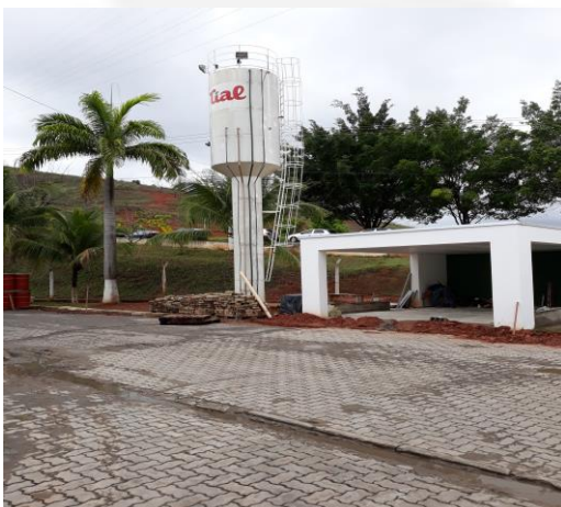
Foto 05: Caixa d'água da empresa.
