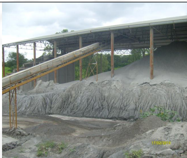
Foto 06: Baias de armazenamento do pó de calcário
