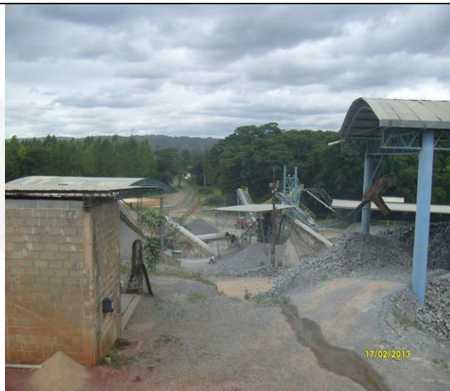
Foto 04: Vista da montante para jusante
