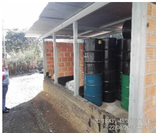
Foto 04: Armazenamento de resíduos
