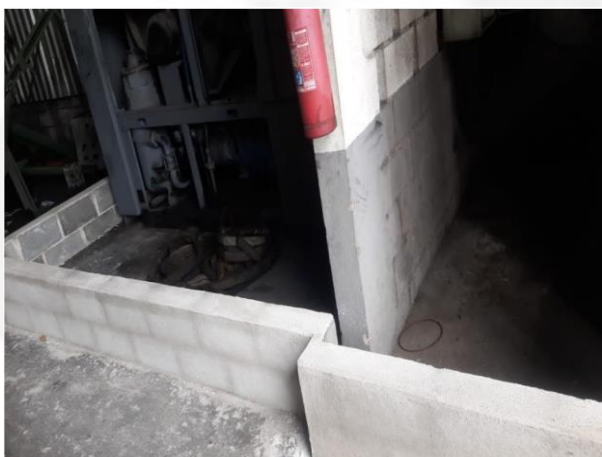
Foto 03: Bacia de contenção do compressor
