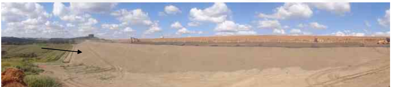
Foto 03. Visão lateral do processo de reconformação do maciço da BL-1
