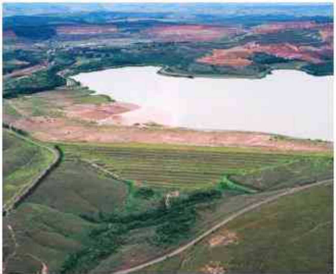
Foto 01. Visão da Barragem BL-1, antes do processo de reconformação.
