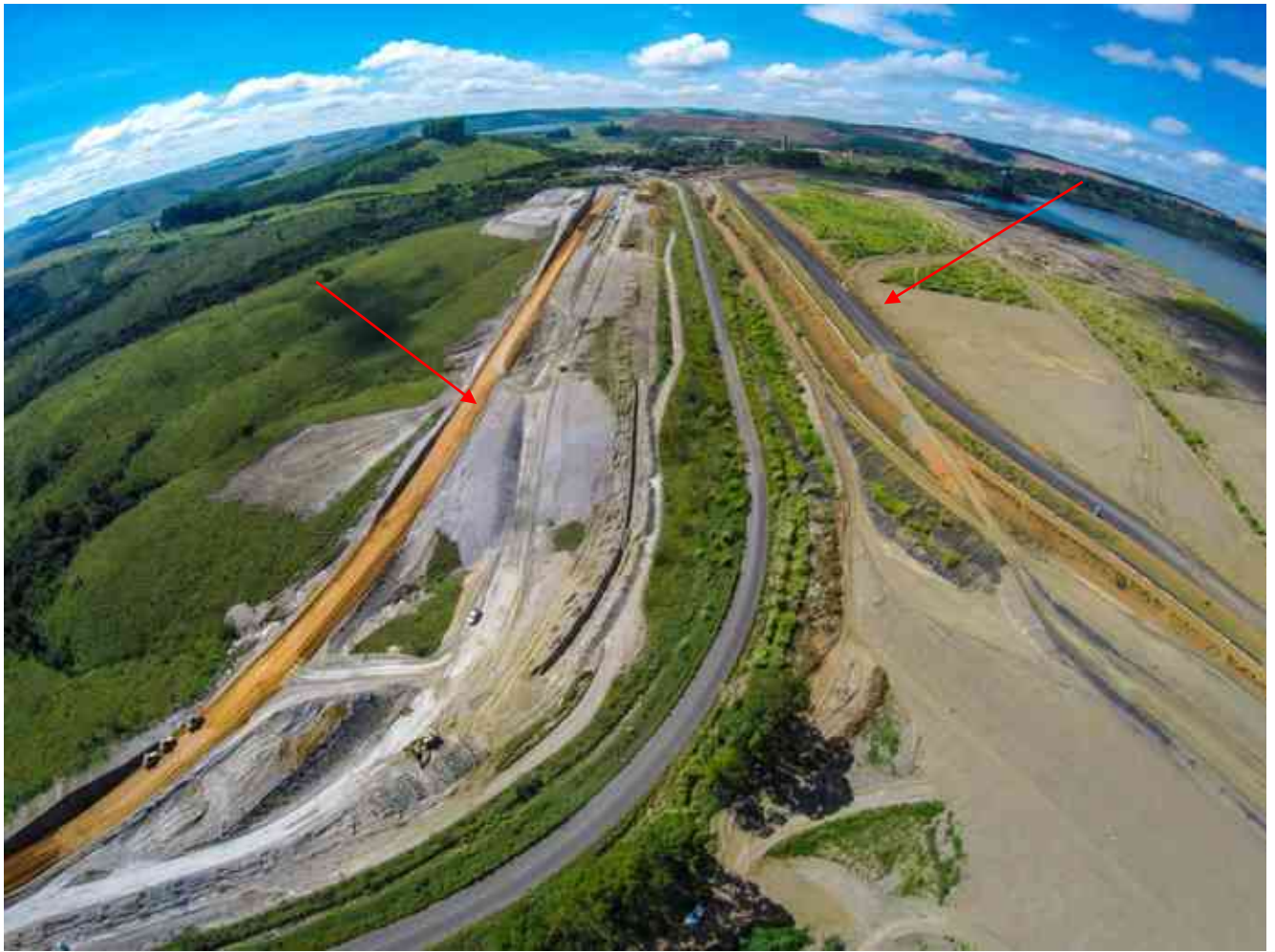
Foto 13. Relocação da MGC-146 e ombreira direita da Barragem BL-1.
