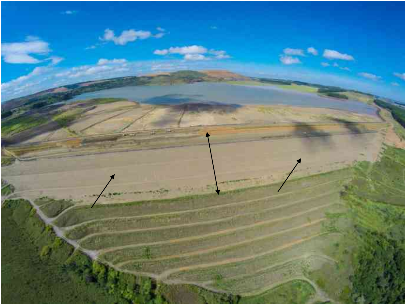
Foto 02. Visão geral da Barragem BL-1 em processo de reconformação do maciço para método linha de centro.
