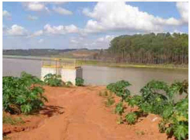
Foto 07. Torre extravasora da BL-1.
