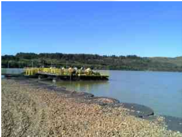
Foto 06. Balsa de captação de água – recirculação.
