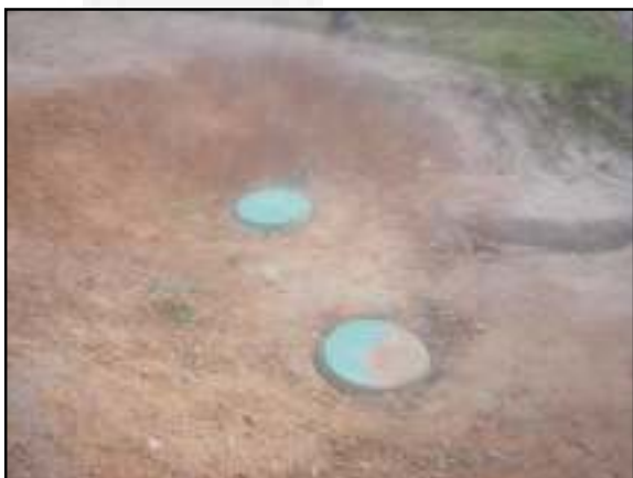
Foto 03: Sistema de Tratamento do Efluente Sanitário.
