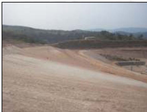
Foto 04: Recuperação do maciço de resíduos antigo.
