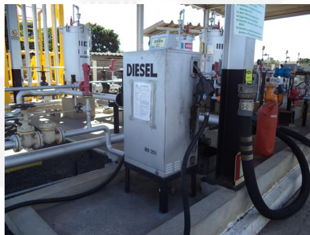
Foto 04. Bomba de diesel
