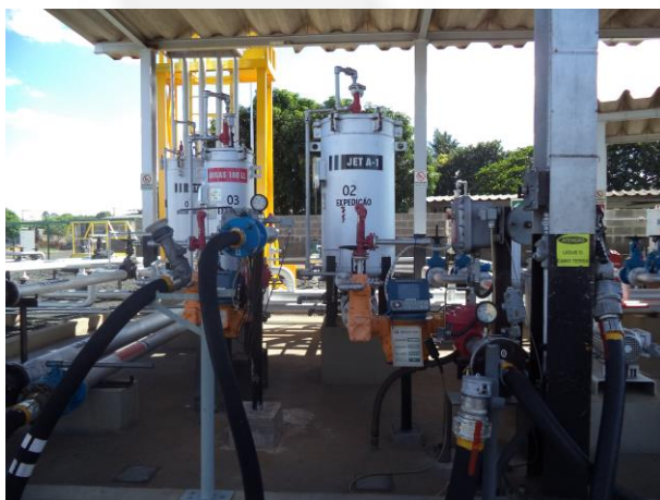
Foto 03. Bombas de descarga e carga
