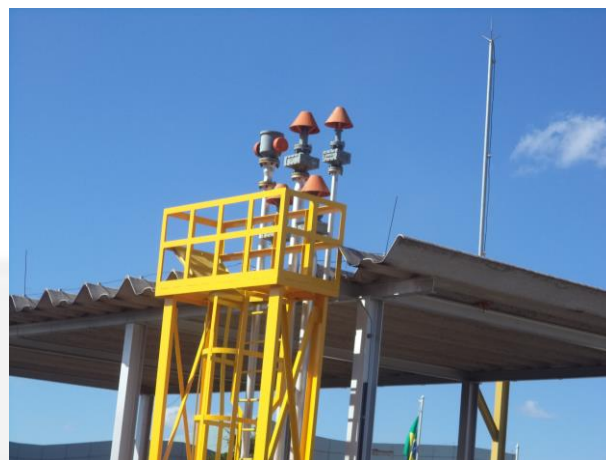
Foto 06. Respiro dos tanques
