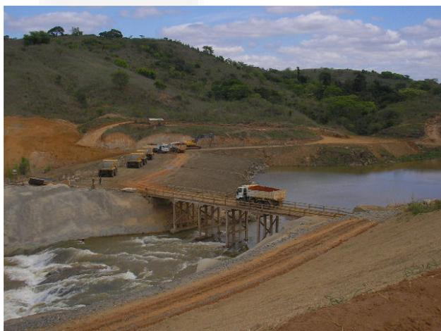
**Foto 03.** Ponte no detalhe foi removida para enchimento.
