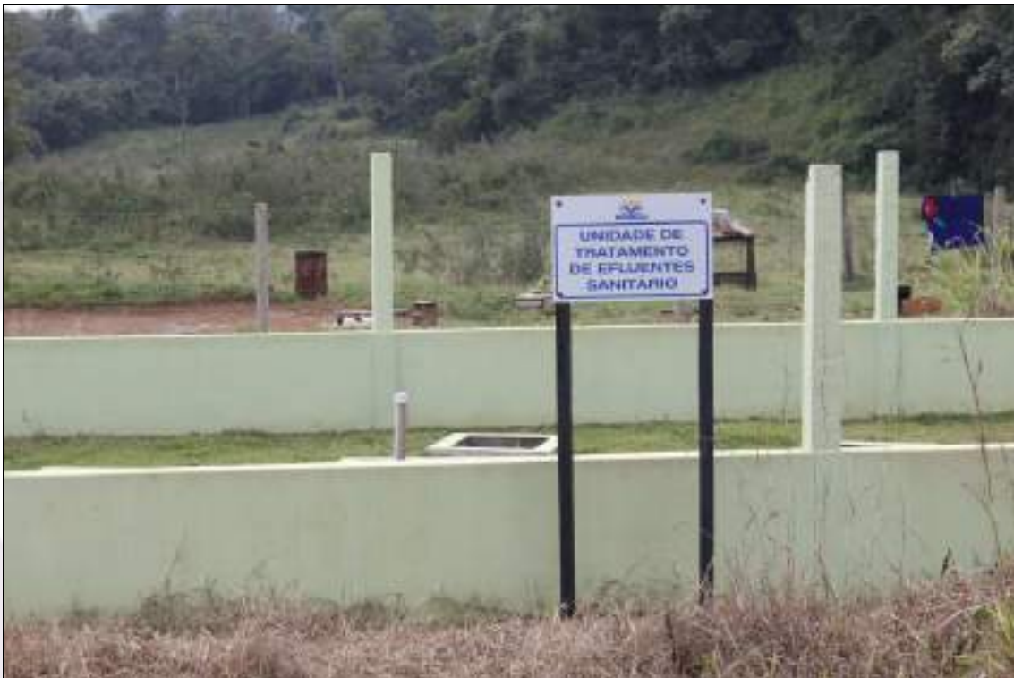
Foto 01: Vista para Unidade de Tratamento de Efluentes Sanitários da AGRO-CAMPO
