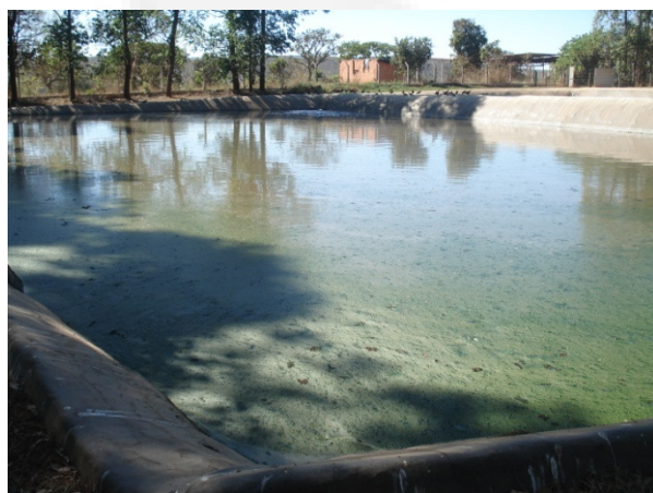
Foto 3: Lagoa de estabilização
