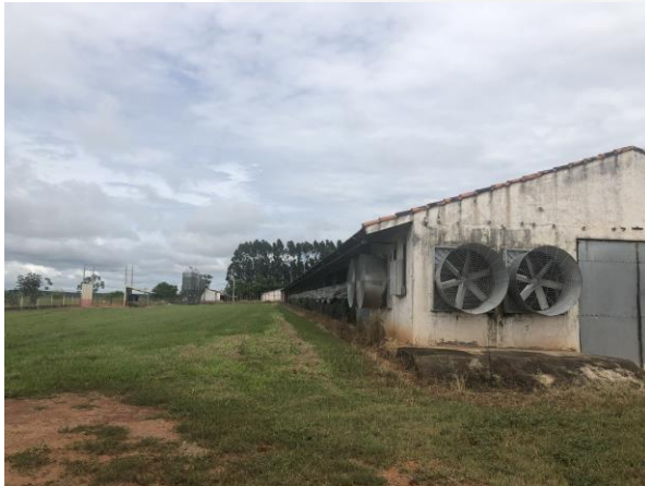
Foto 01. Galpão de aves que será reformado
