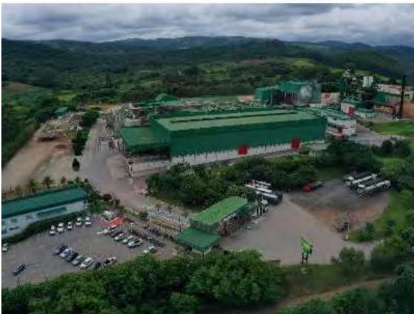
Foto 01 - Visão geral do empreendimento
