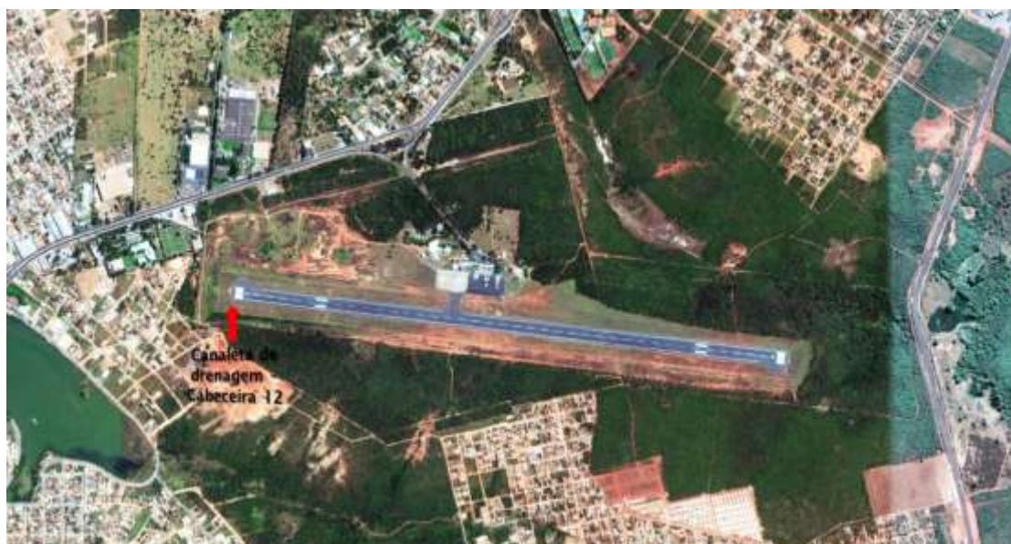
Figura 12 – Localização do ponto de amostragem para águas pluviais. Seta vermelha indica a canaleta de drenagem pluvial onde foi realizada a coleta.
