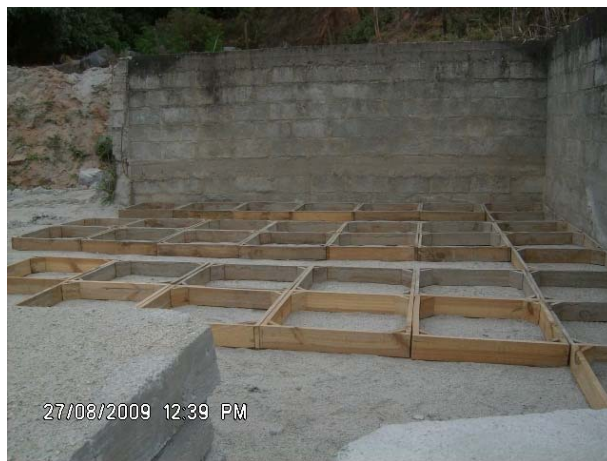
Foto 02. Reciclagem de concreto rejeitado.
