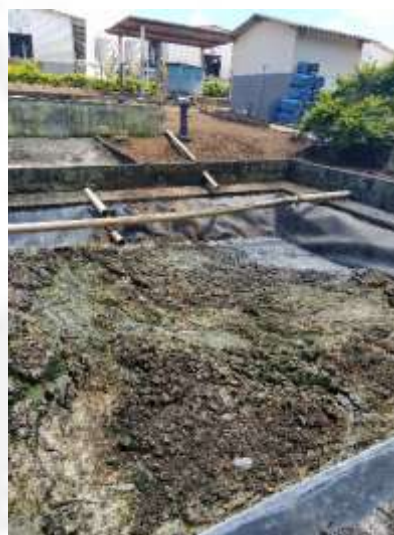
Foto 04. ETE industrial e leito de secagem
