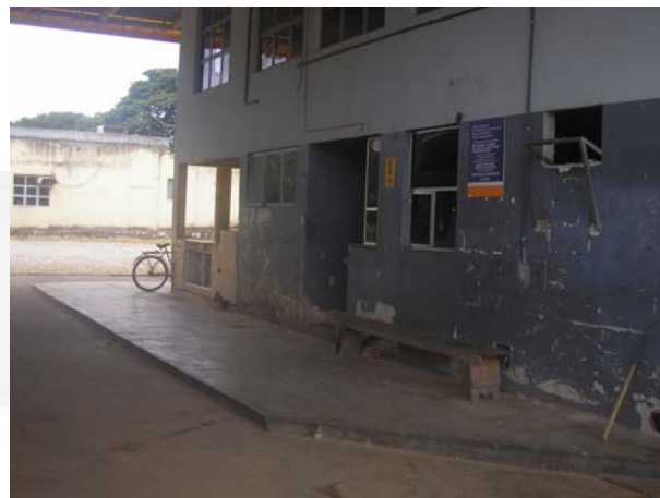
Foto 02. Estruturas antigas do Posto desativado
