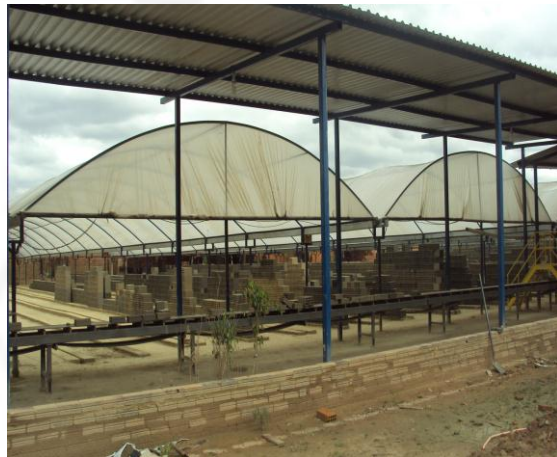
Foto 8: Estufas de secagem dos tijolos.
