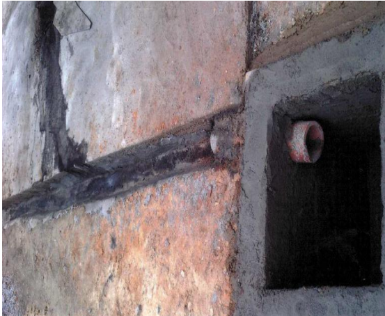
Foto 5: Caixa de sedimentação do depósito de pó de balão.
