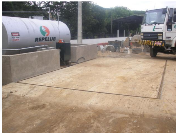
Foto 02. Tanque de abastecimento de óleo diesel.
