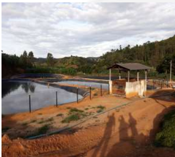
Figura 01: Lagoas de Tratamento
