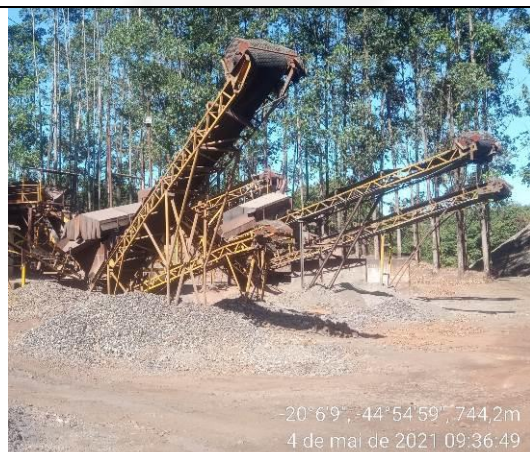
Foto 03. Planta para beneficiamento de escória.
