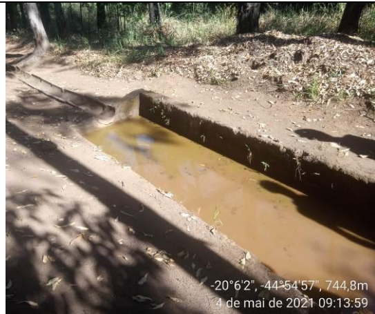
Foto 07. Canaletas e tanque de decantação efluentes pluviais
