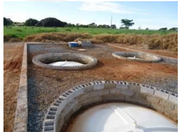
Foto 02. Sistema de caixas sépticas
