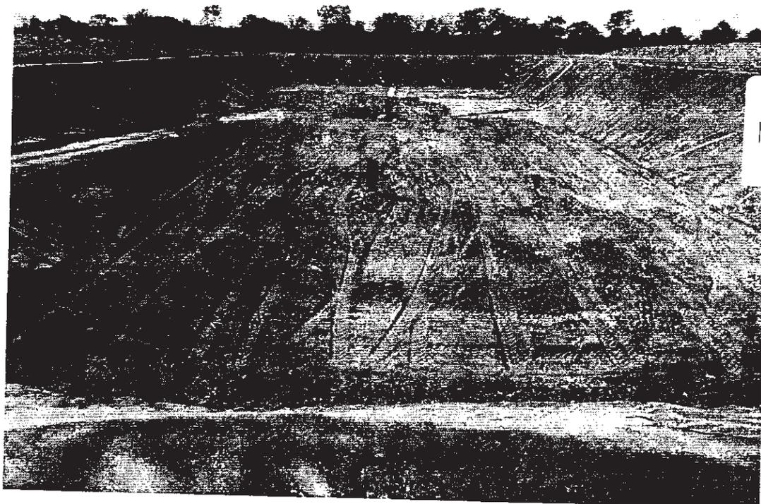
Cobertura da geomembrana com terra para proteção mecânica
