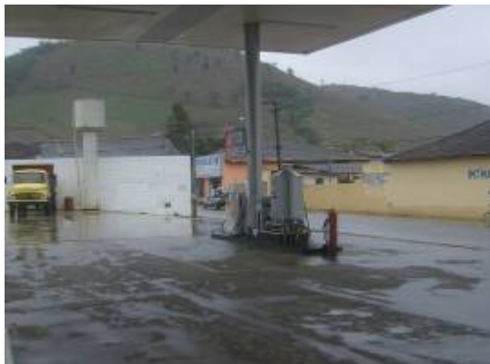
Foto 01: Piso da pista de abastecimento.
