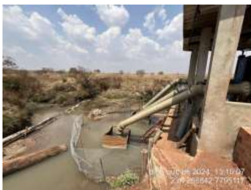
Foto 3. Captação de água superficial. Fonte: Laudo Técnico e fotográfico de Vistoria Remota (2024)/Totus ambiental consultoria e projetos.
