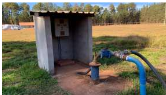
Foto 2. Captação de água subterrânea (poço tubular). Fonte: Laudo Técnico e fotográfico de Vistoria Remota (2024)/Totus ambiental consultoria e projetos.
