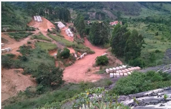
Foto 3. Área de depósito de blocos.
