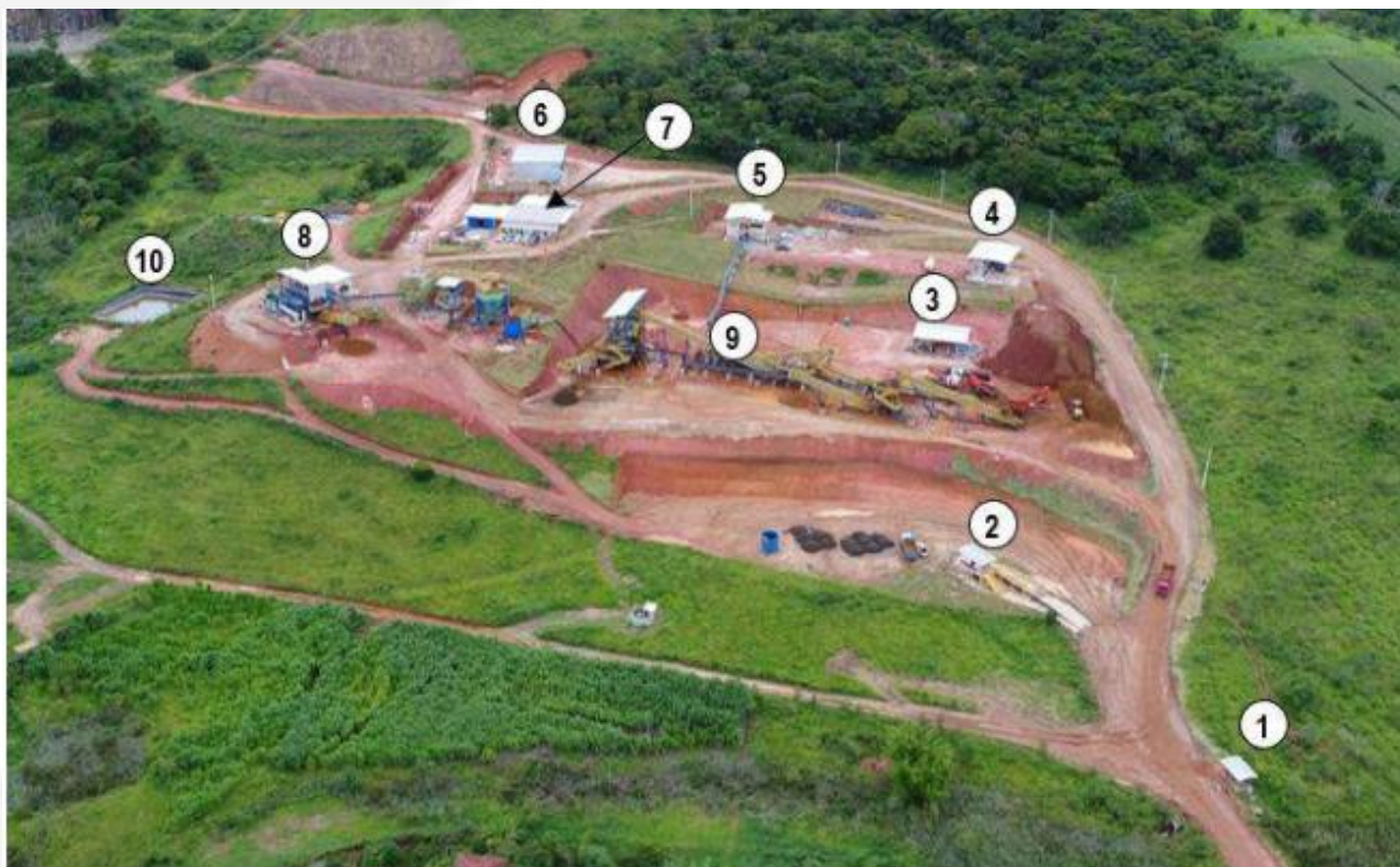
Figura 02 - Vista geral da Infraestrutura do Empreendimento. (1) Portaria (2) Balança Rodoviária; (3) Oficina mecânica; (4) Posto de combustível; (5) CCM/Escritórios; (6) Oficina Diesel/lavador de veículos; (7) Estacionamento/Escritórios/Vestiários/Almoxarifado/Laboratórios Químico e Físico/Refeitório; (8) Filtro Prensa; (9) Beneficiamento e (10) Tanque de Lona (reservatório hídrico).
