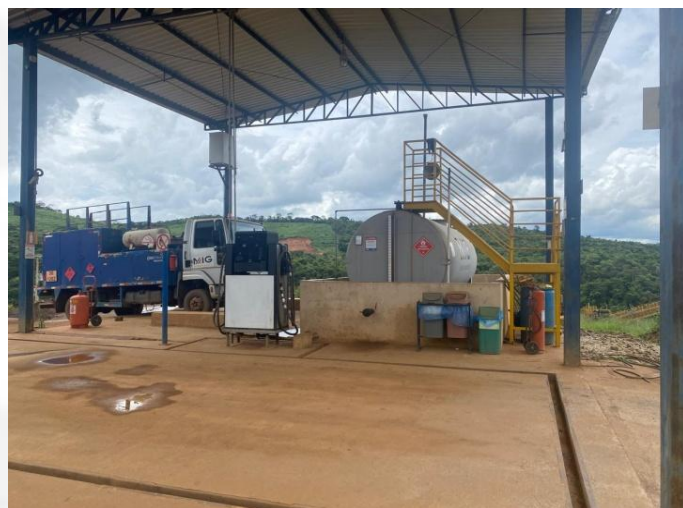
Foto 02. Ponto de abastecimento
