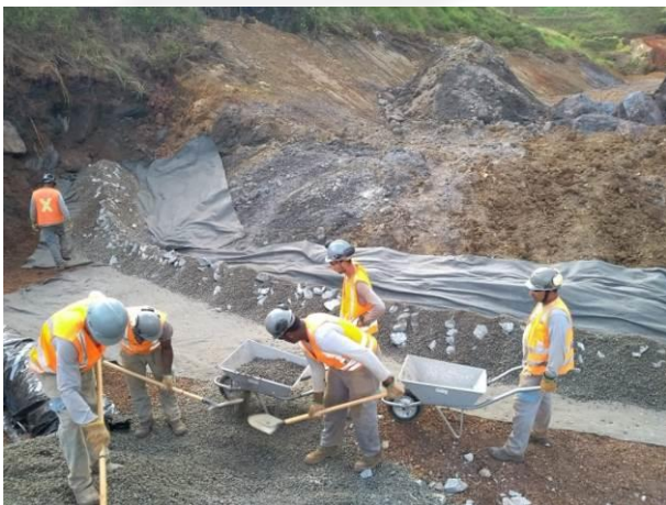
Figura 5: Dreno de fundo da pilha
