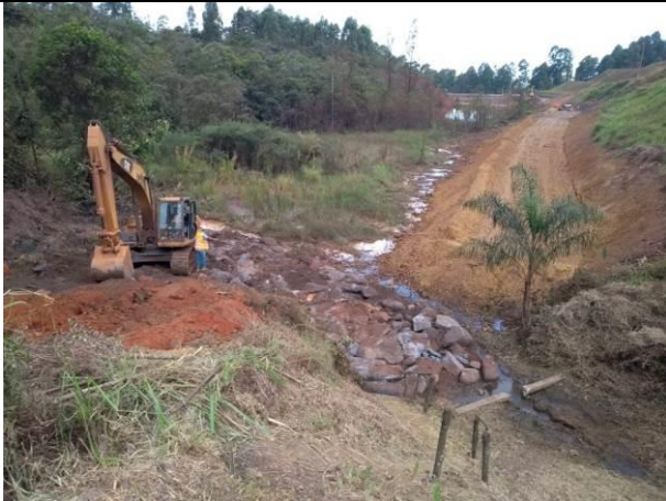
Figura 3: Obras de implantação da ampliação da pilha.
