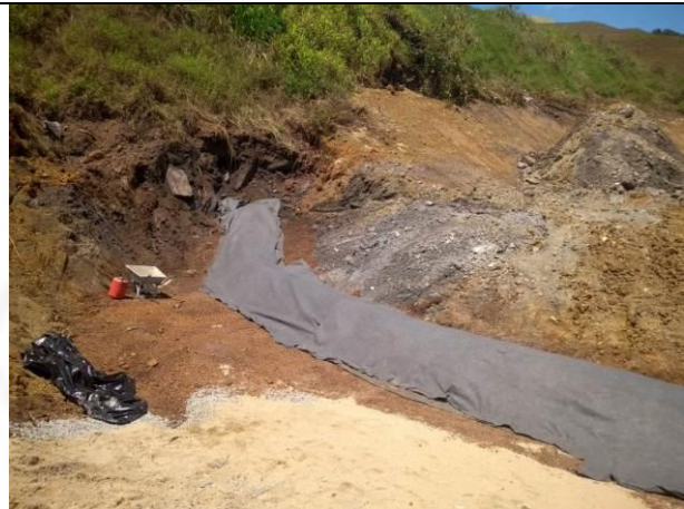
Figura 6: conclusão do dreno de fundo da ampliação da 1 etapa de ampliação da pilha
