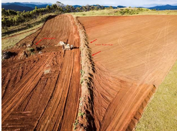
Figura 9: estrada de acesso interno implantada
