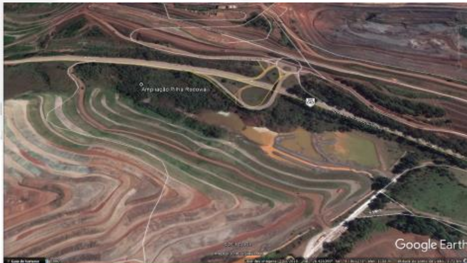
Figura 16: Pilha da Rodovia atual e a área onde ocorrerá a ampliação.
