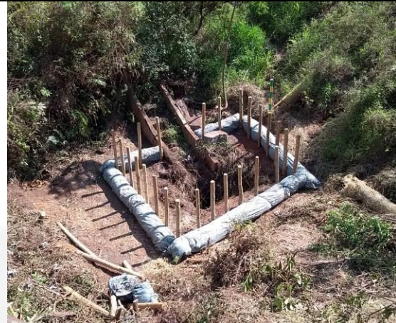
Figura 14: implantação de sistema de controle interno da pilha
