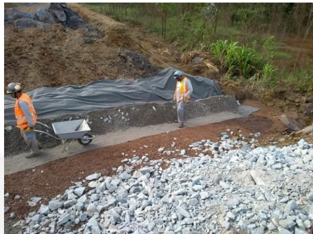
Figura 4: ampliação do dreno de fundo
