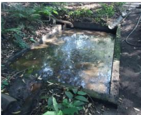
Foto 09. Tanque de decantação de efluentes pluviais.
