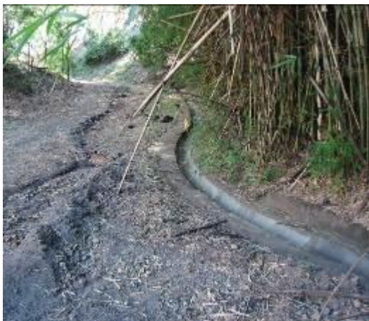
Foto 07. Canaletas para drenagem pluvial.
