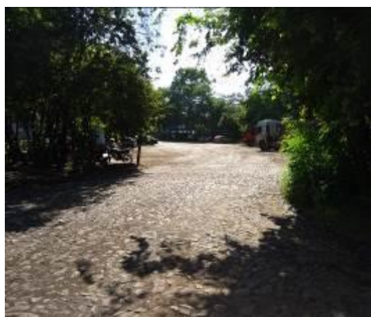
Foto 10. Via interna pavimentada.
