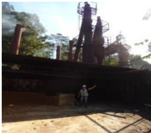
Foto 01. Sistema de limpeza de gás e chaminés
