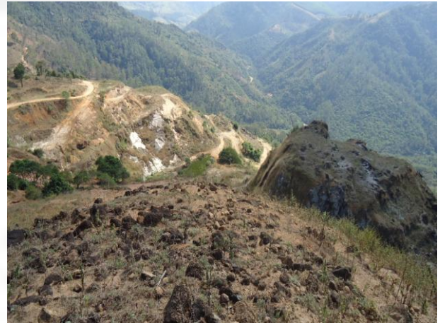
Foto 02. Degradação da área atualmente.
