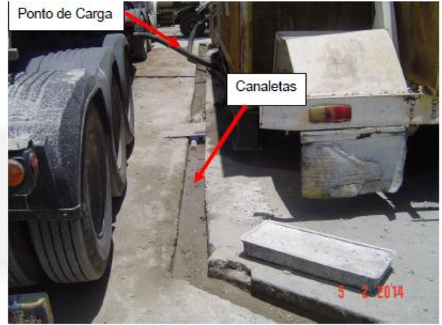
Foto 02 – Canaletas Fonte: RADA
