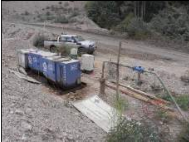
Foto 05. Poço tubular instalado na cava Rosalino referente ao rebaixamento de nível d'água, dotado de equipamento hidrométrico e gerador
