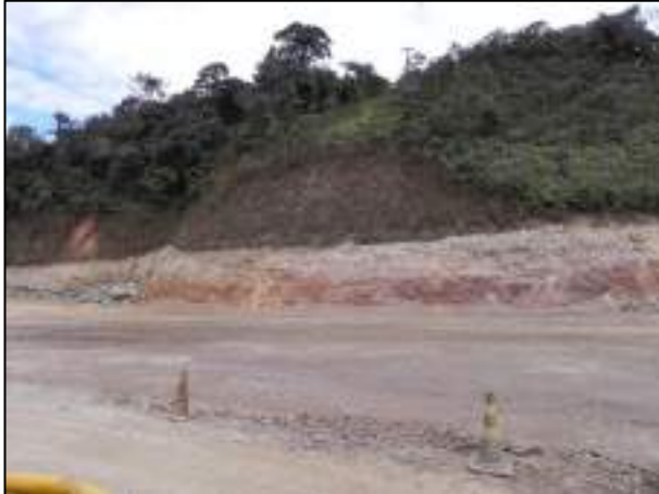
Foto 01. UTM - Pátio de Estocagem
