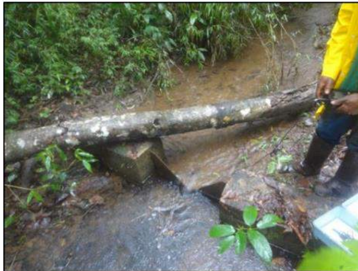
Figura 19: Ponto de monitoramento com o vertedouro MCSSP1006
