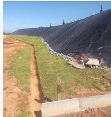
Foto 4: Sistema de drenagem pluvial do Aterro classe I encerrado.
