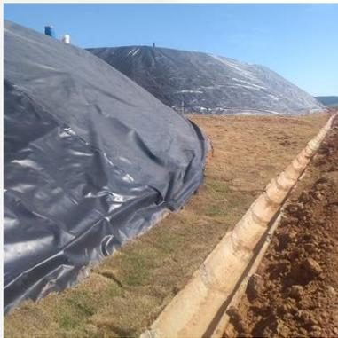
Foto 3: Aterro classe I encerrado – Vala 1 e 2 e calha de drenagem
