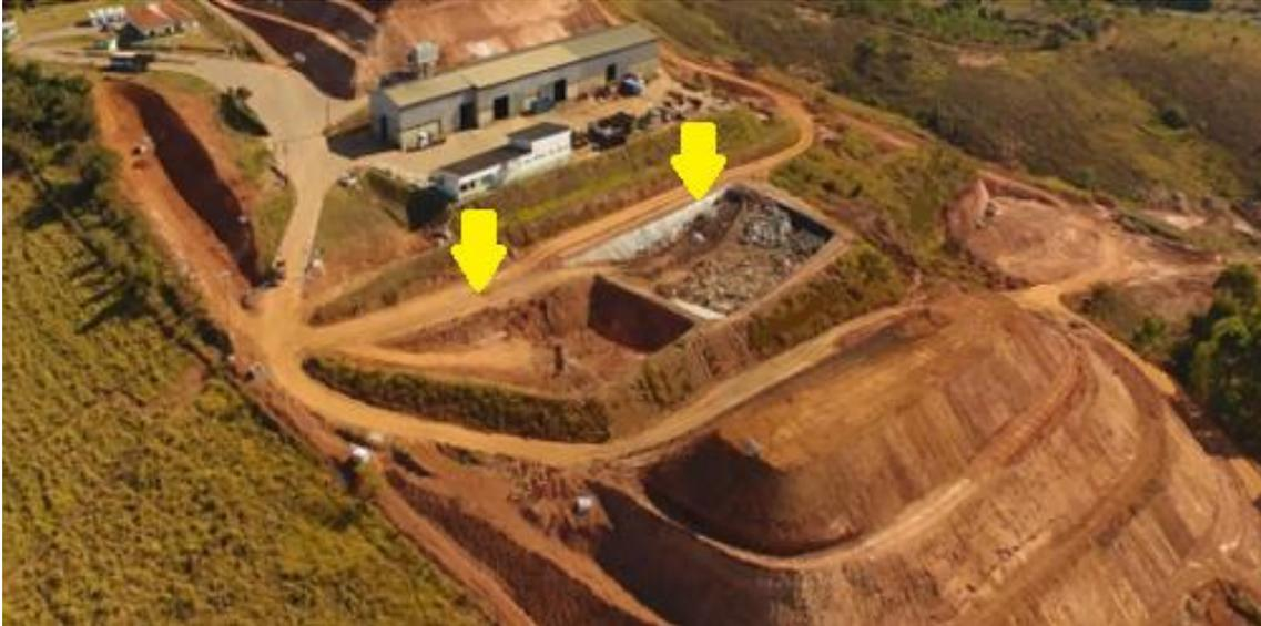
Figura 10: Célula de ampliação de resíduos não perigosos – Aterro Classe II – Fonte: Ecosust
