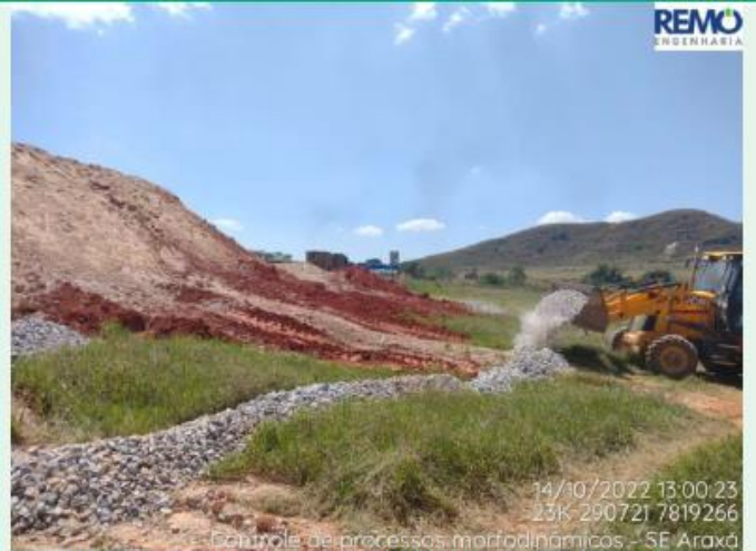
Foto 4.1-94: Aplicação de pedra de mão para contenção de sedimentos.
