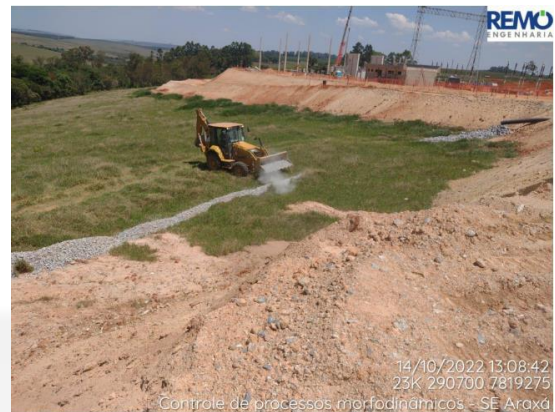
Aplicação de pedra de mão para contenção de sedimentos
