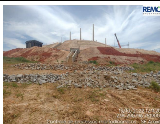
Reconformação de talude e utilização de curva de nível em formato "meia lua" para retenção e filtração de materiais.
