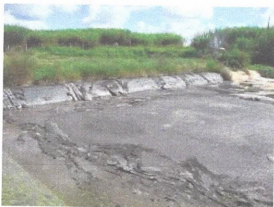
Um dos biodigestores com a lona superior queimada.
