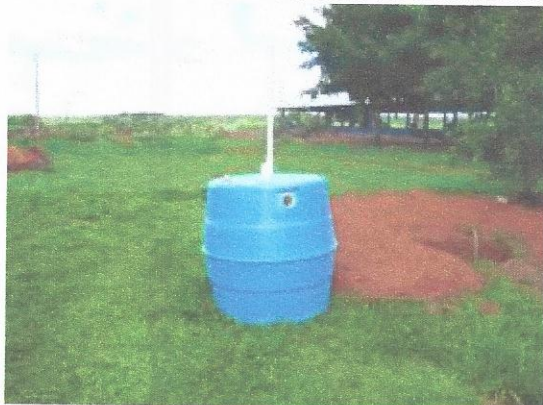
Fossa biodigestora sendo instalada na propriedade.
