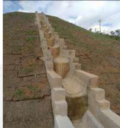
**Foto 02.** Drenagem de água pluvial
