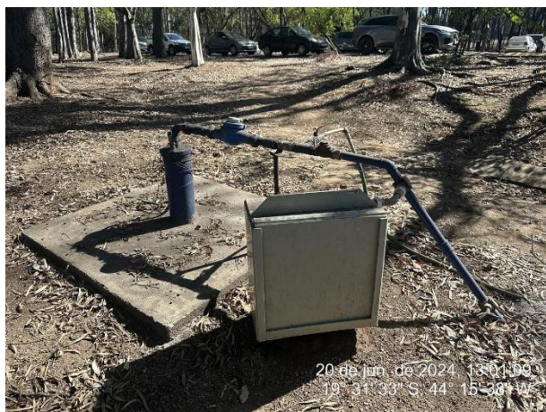
Foto 97: Poço tubular em operação.
