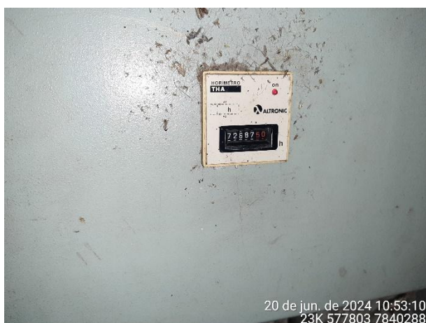
Foto 95: Horímetro do ponto de captação 03.
