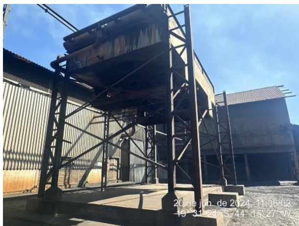
Foto 19: Ventiladores que compõe sistema de resfriamento da termelétrica
