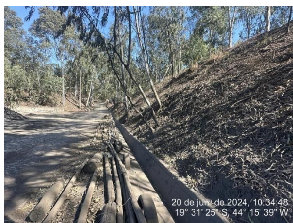
Foto 22: Canaleta de drenagem próximo ao pátio de matéria prima
