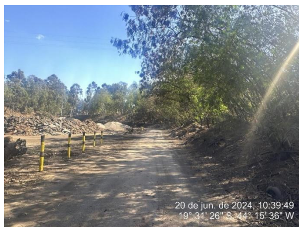
Foto 24: Ausência de canaletas de drenagem em via próximo ao pátio de matéria prima
