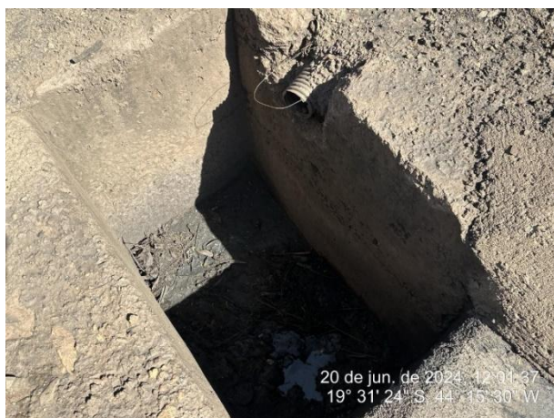
Foto 29: Caixa de passagem de água pluvial próxima ao galpão de carvão
