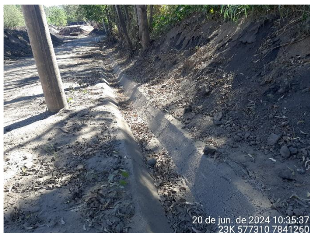
Foto 86: Canaleta sendo construída ao longo do acesso a pilha de escória.
