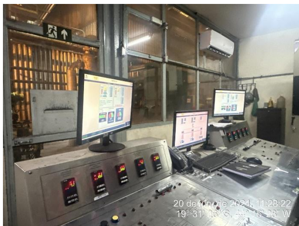
Foto 17: Painel de controle - Termelétrica
