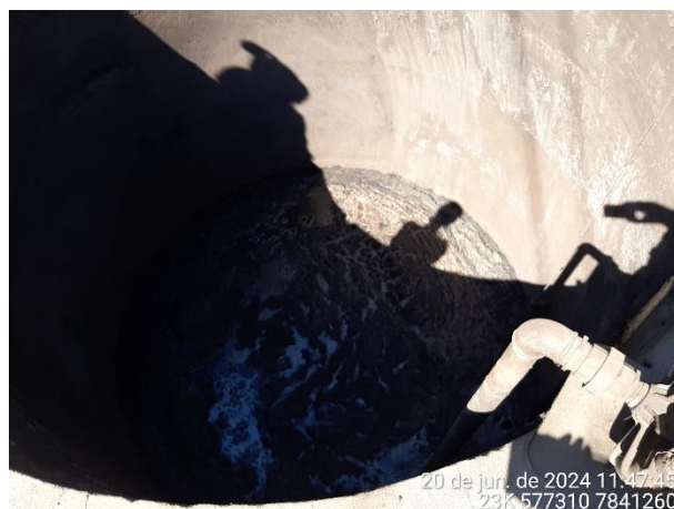
Foto 104: Estrutura de alvenaria onde fica armazenado o efluente para ser posteriormente bombeado para a caixa do filtro presa e retornar ao sistema de lavagem de pó.
