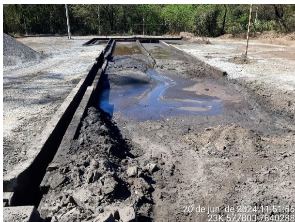
Foto 103: Tanque de decantação de pó de balão.
