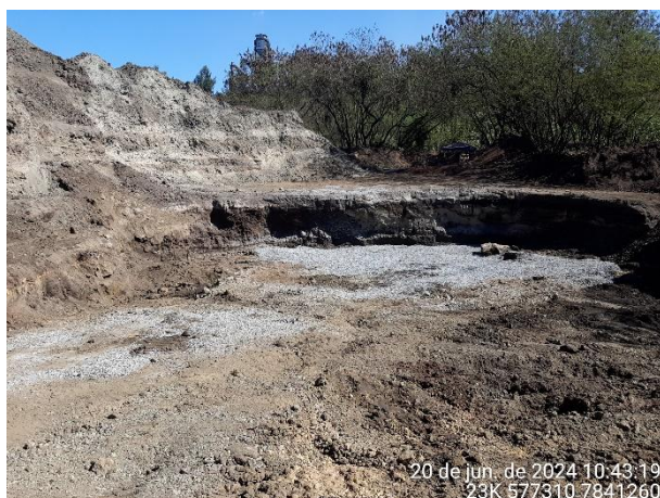
Foto 83: Bacia de contenção sendo construída no pé da pilha de escória.
