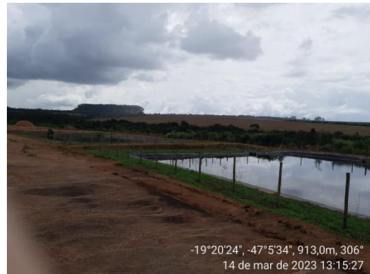
Foto 6. Lagoas de tratamento do efluente do pátio de compostagem
