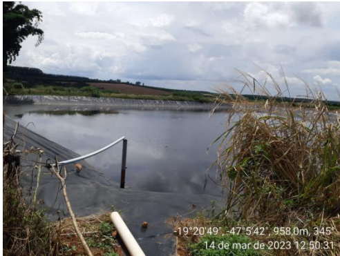
Foto 1. Lagoa de águas residuárias do beneficiamento de grãos
