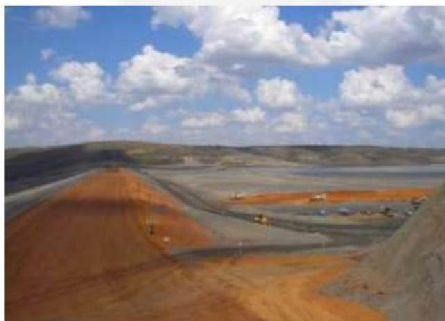
Foto 07. Barragem Eustáquio (alteamento)
