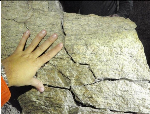
Foto 5: Desfragmentar de bloco no interior da cavidade não sendo possível avaliar se trata-se a origem da causa.
