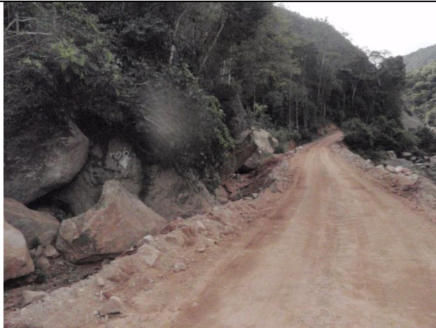
Foto 11 A esquerda da estrada localização onde se encontrava o conduto que foi suprimido da Cav 07
