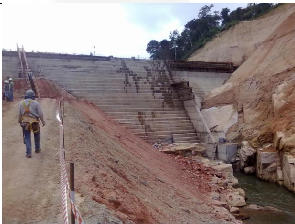
Foto 02. Eixo do barramento, visto da ensecadeira de jusante, e estrutura de desvio.
