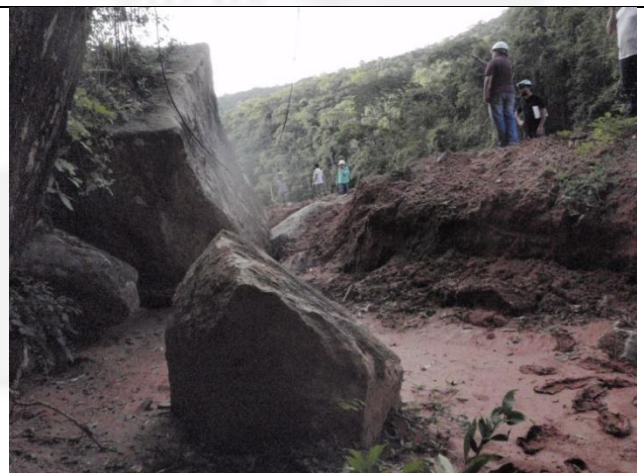
Foto 10: Entrada da cavidade impactada
