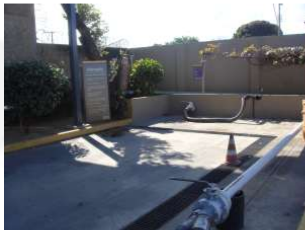
Foto 02 – Plataforma de descarregamento rodoviário
