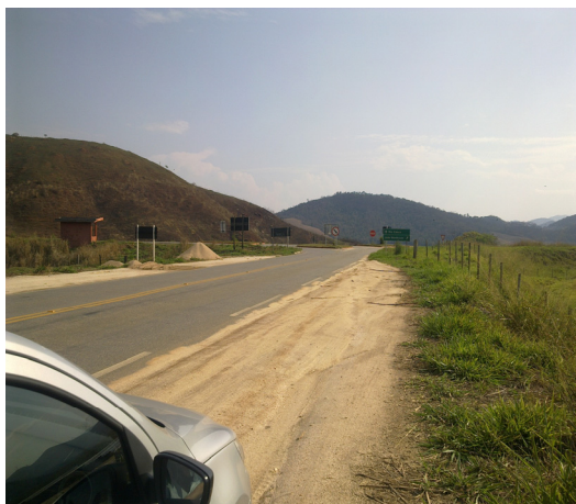
Foto 01. Início do trecho LMG 432.
