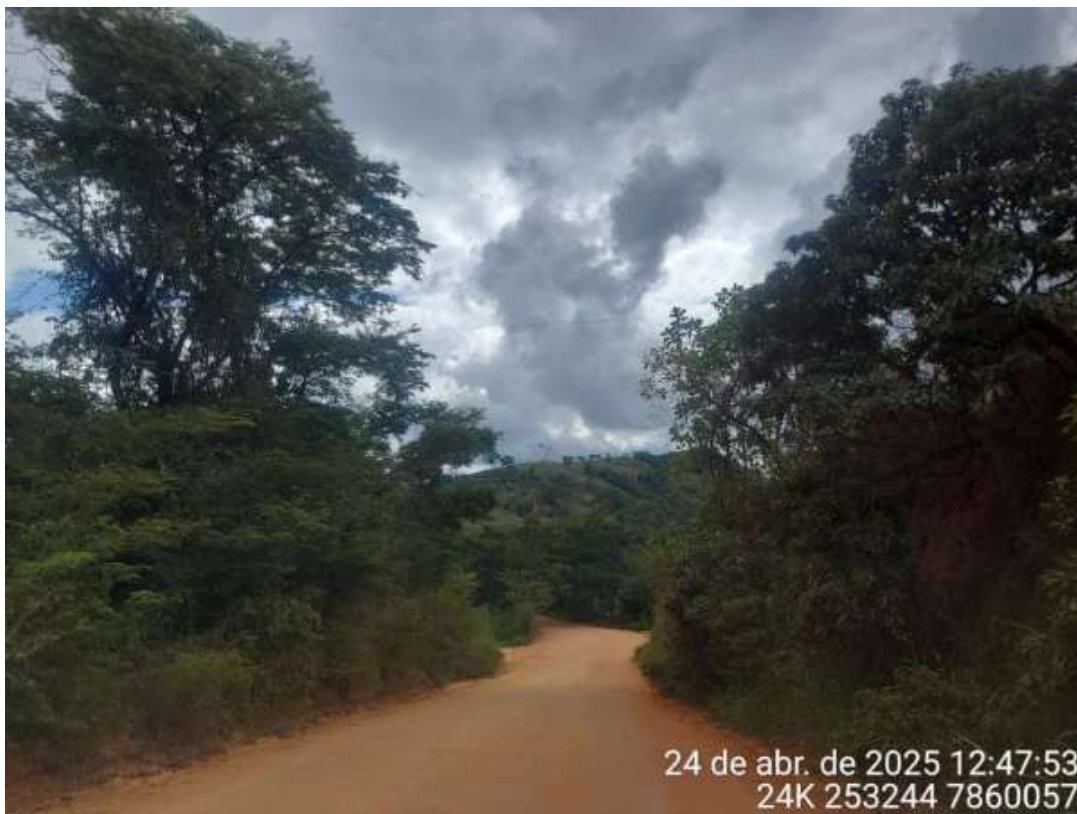
Imagem 3: Área da Vistoriada.
