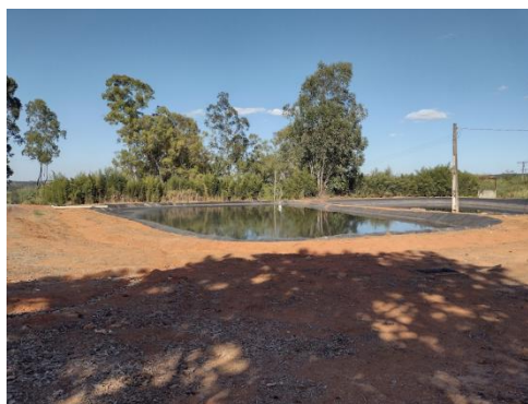
Lagoas de tratamento de efluentes
