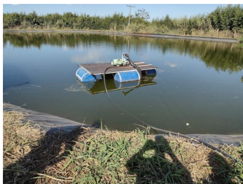
Barragem para armazenamento de água
